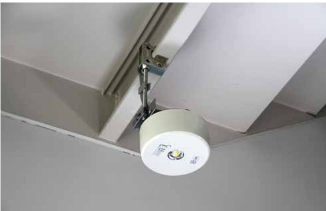
倉庫 [吊りボルト用（垂直方向・アクセスポイント）]
