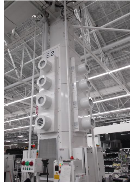
柱や壁面に固定したフレームに室内ユニットとパネルを取り付けた自立システム設置型
